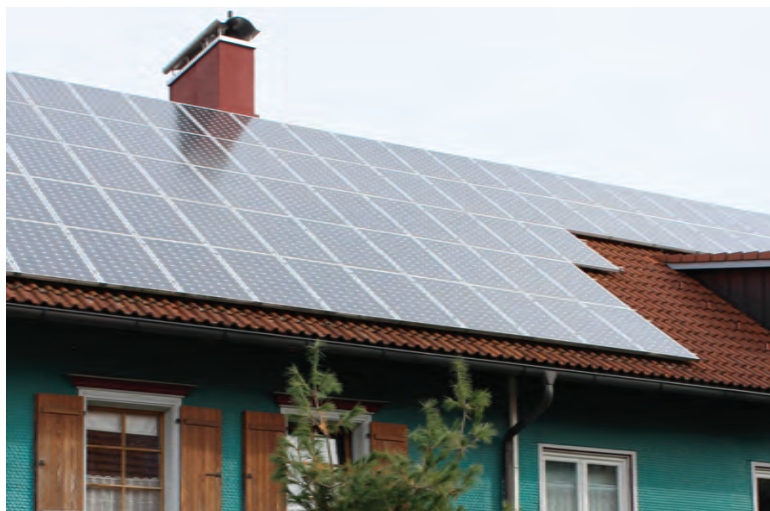
61 Einfamilienhaus in regional-typischer Bauweise mit historischer Schindelfassade und zukunftsweisenden Solarzellen
