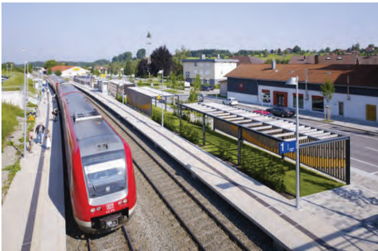
62 Bahnhof in Heimenkirch Foto: Marc Lins
