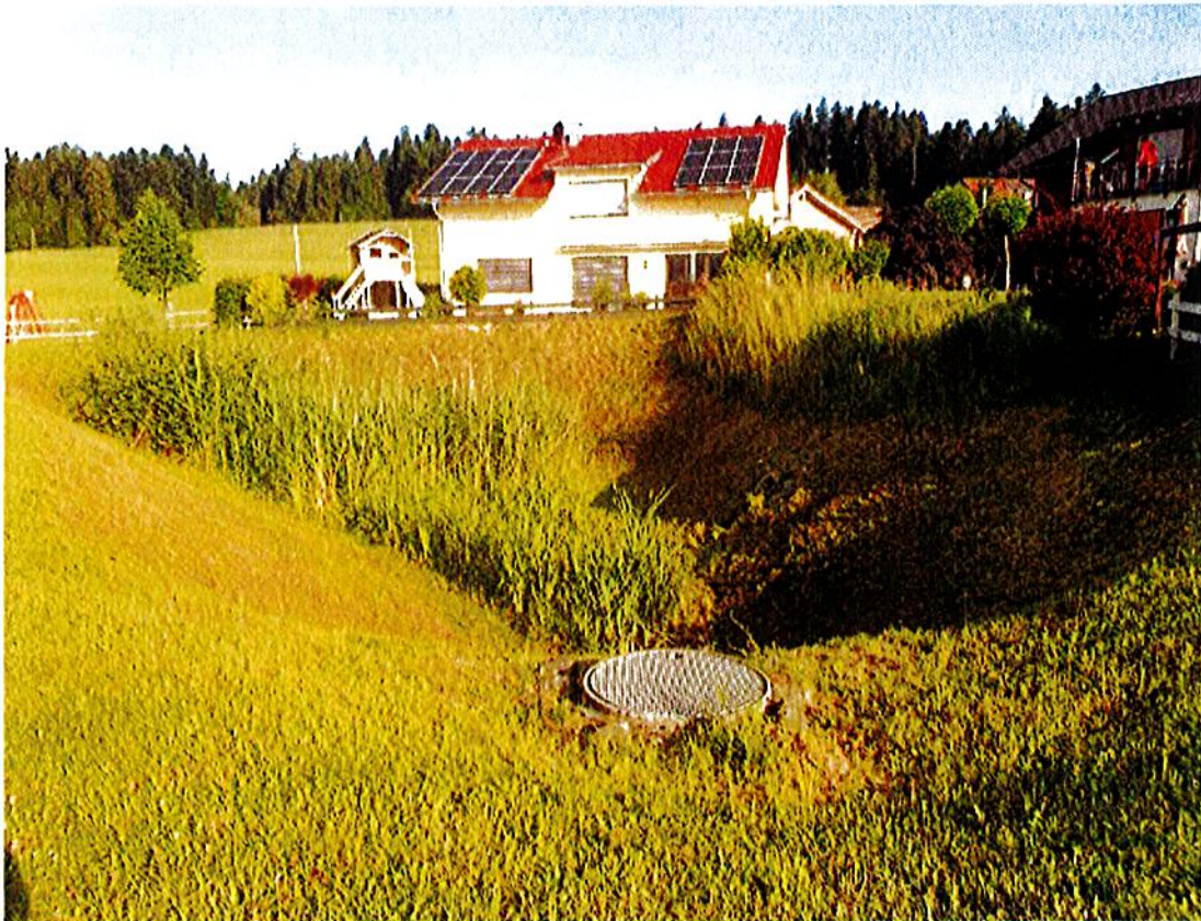
Abbildung 3: Regenrückhaltebecken in „Böserscheidegg Süd“ mit Metallschutzgitter des Drosselbauwerkes als Notüberlauf
